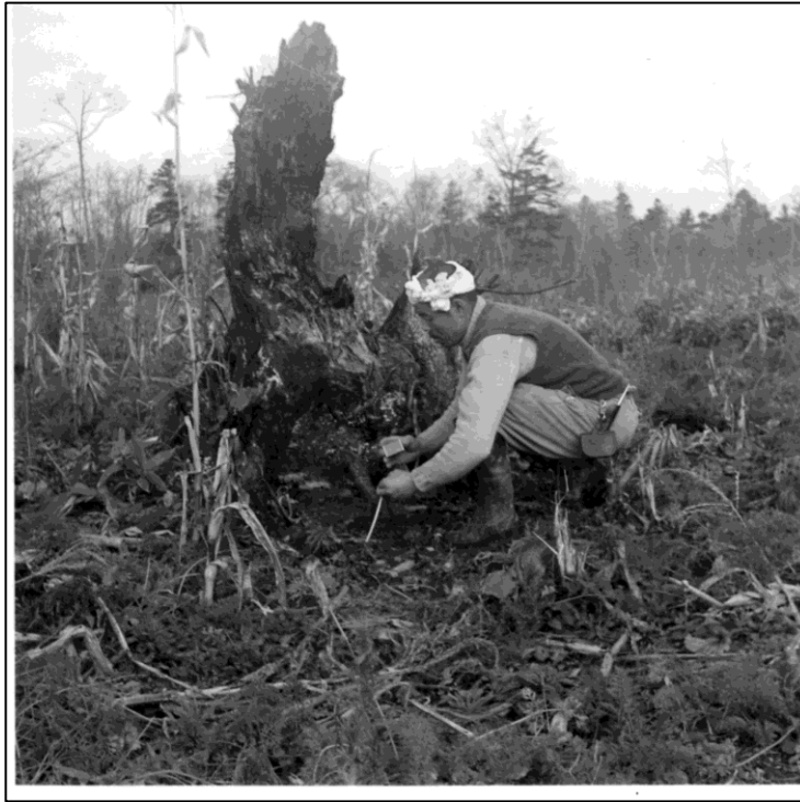
根株に火薬と導火線を付ける
